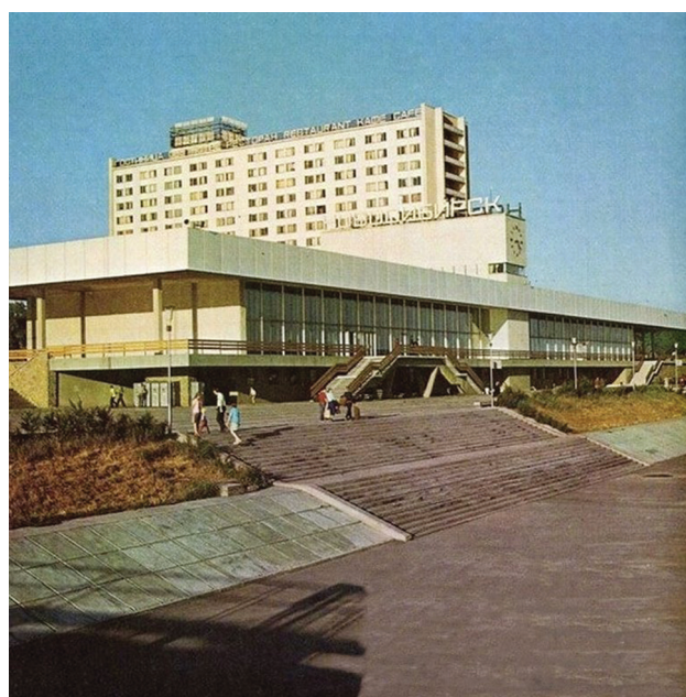
Здание речного вокзала
