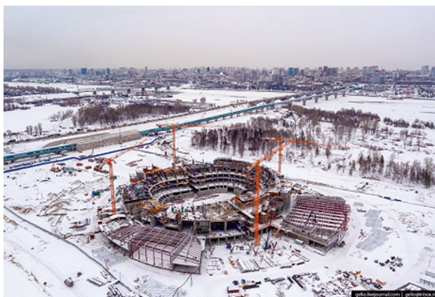
Строительная площадка «Многофункциональной ледовой арены...»
