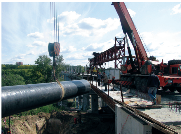
Трест «Строймеханизация», строительство напорного коллектора в Академгородке
