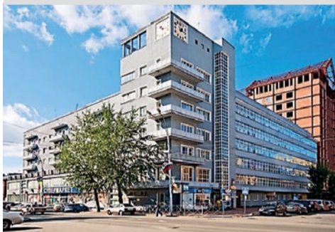
Дом «с часами» на Красном пр., 11. Вход в квартиры — из светлых остекленных галерей, опирающихся на консоли. На левом крыле галереи расположены со стороны двора. Международное общество охраны памятников архитектуры DOCOMOMO признало его одним из лучших мировых творений архитектурного авангарда.
