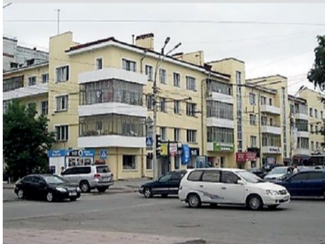
Дом-коммуна на Красном пр., 49. Первоначально в нем были крохотные кухни и отсутствовали ванны, поскольку питаться все должны были в общественной столовой и мыться в общественной бане. В наст. время — обычный многоквартирный дом.
